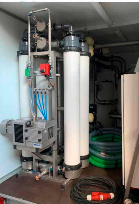
Die mobile Trinkwasserversorgungsanlage mit dem dazugehörigen Ersatzstromaggregat
